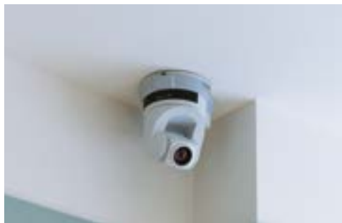
◀ INSTALAÇÕES do Centro de Medicina do Sono do hospital CUF Porto
